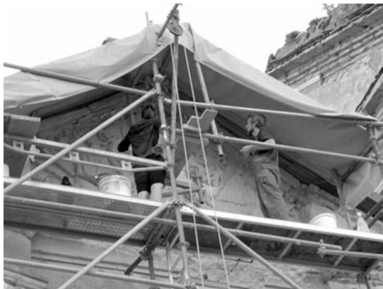
Prace przy kamiennym osiemnastowiecznym portalu bocznego wejścia do klasztoru oo. paulinów w Kamieńcu Podolskim
