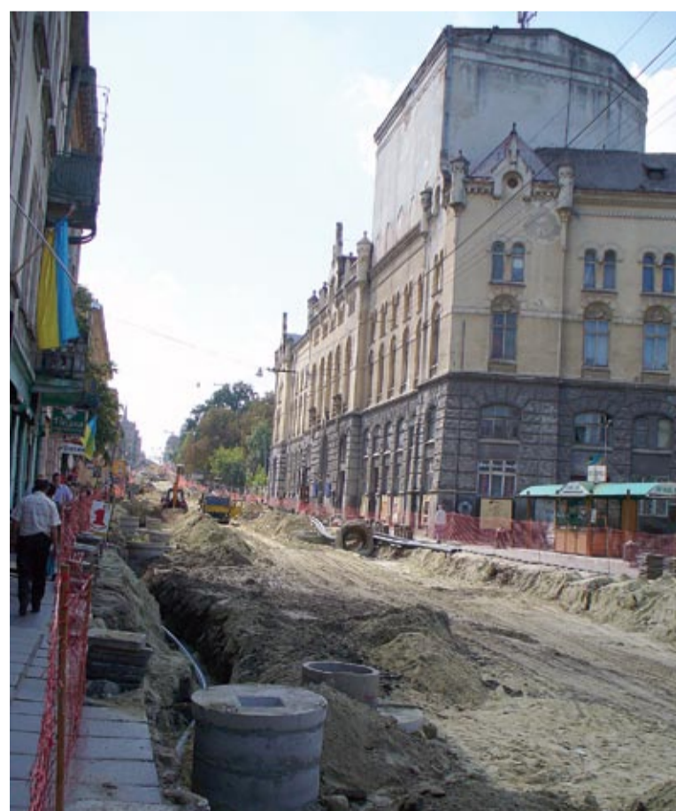
Lwów w remoncie. Tak wygląda obecnie ul. Gródecka
