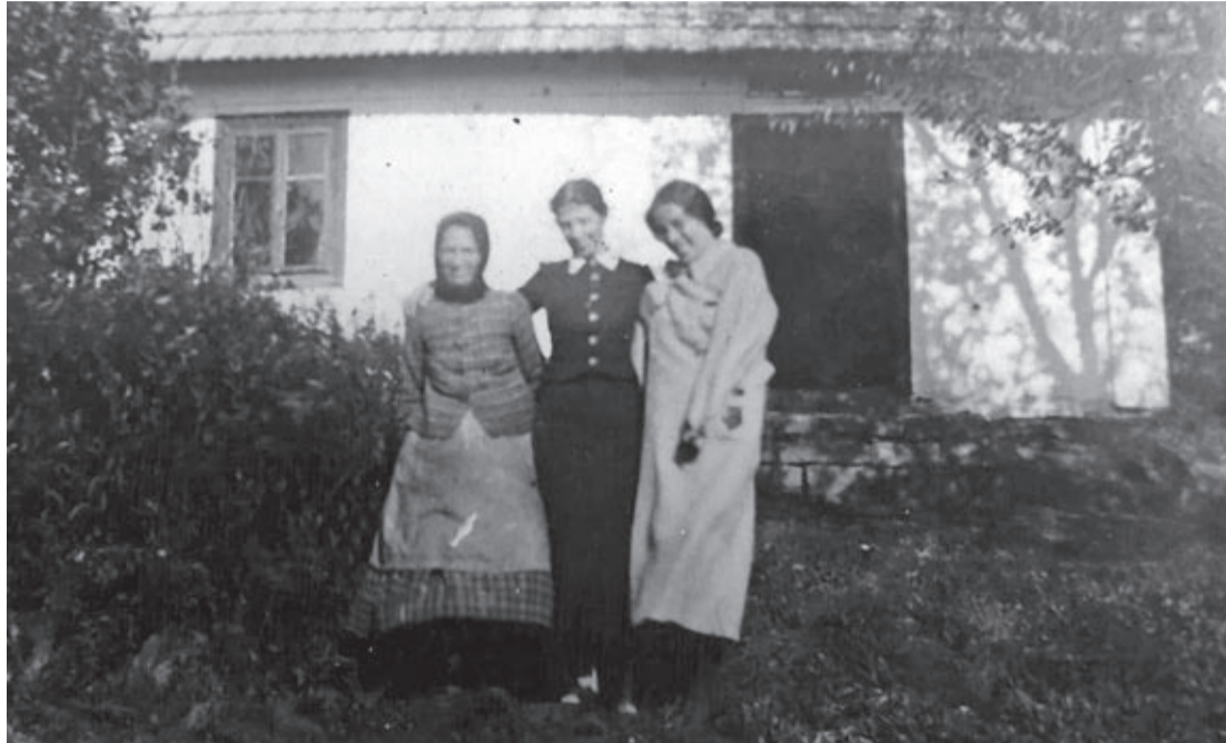
Chata Hawryluka. Zbudowana z gliny na szkielecie drewnianym przed rokiem 1911 – prawdopodobnie w 1890 r. Zdjęcia z okresu międzywojennego. Rozebrana w 1975 r.
