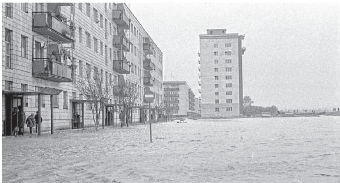
Zalane bloki na ul. Nadbrzeżnej
