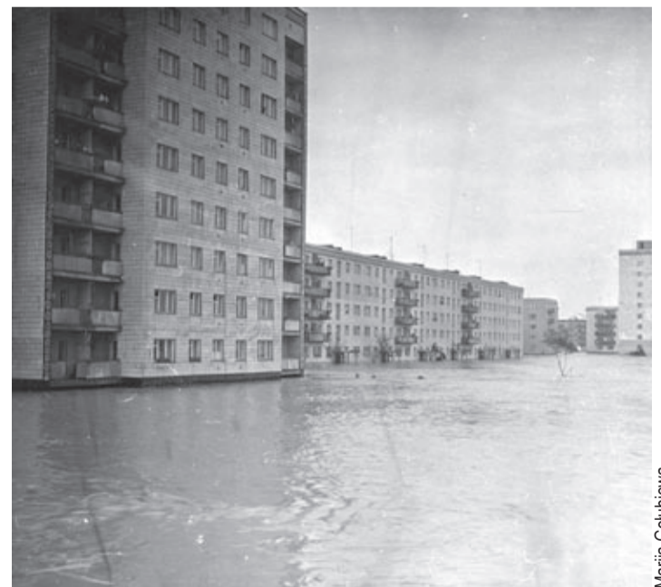
Panorama ul. Nadbrzeżnej od strony mostu
