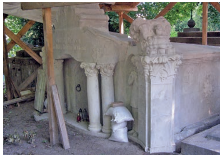
KOLEJNY ODNOWIONY GROBOWIEC
