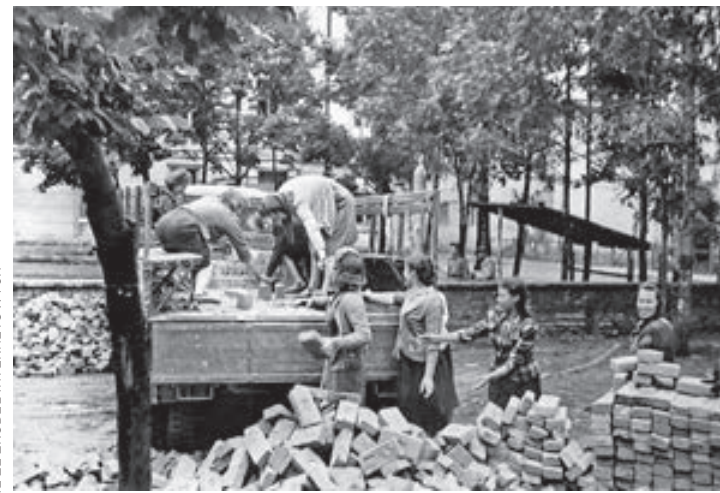
„NIEDZIELNIK” PRZY BUDOWIE CMEN TARZA-POMNIKA ŻOŁNIERZY RADZIECKICH, ROK 1946
