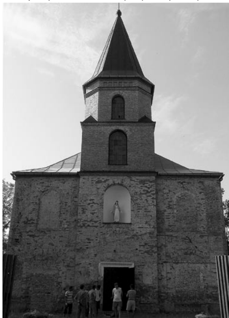
Kościół przed remontem
