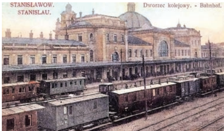
Dworzec kolejowy w Stanisławowie
