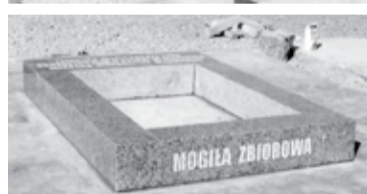
Montaż płyty na mogilę Pięciu Nieznanych Żołnierzy
