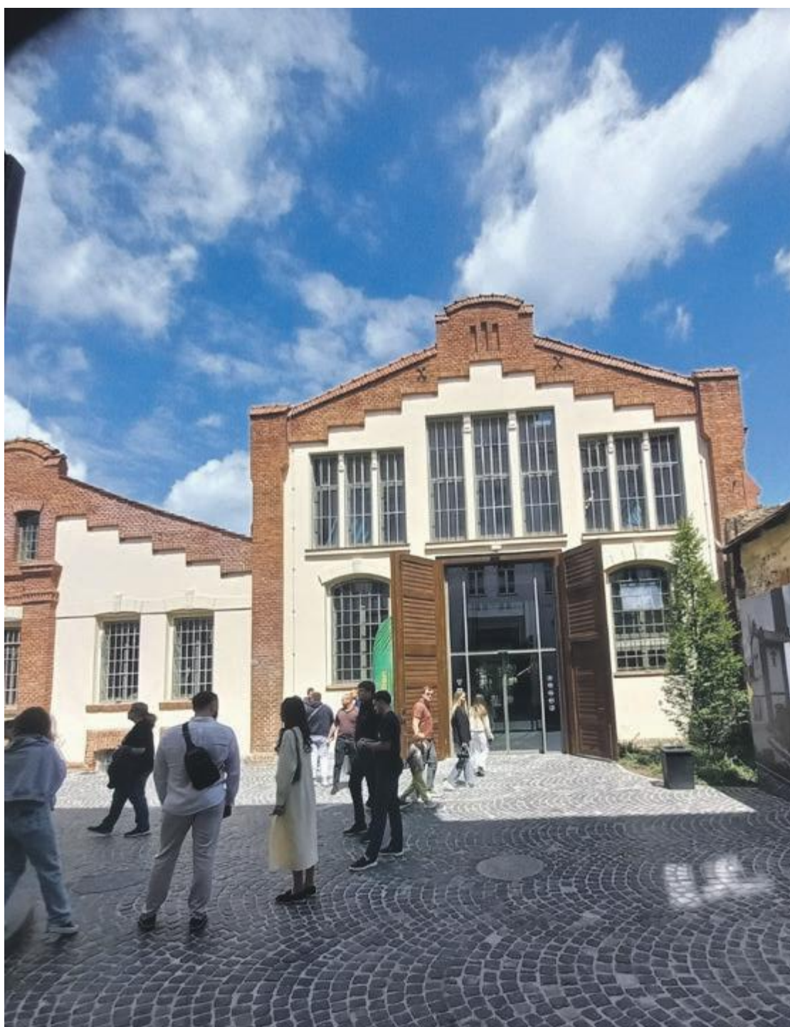
ODNOWIONY BUDYNEK DAWNYCH WARSZTATÓW
