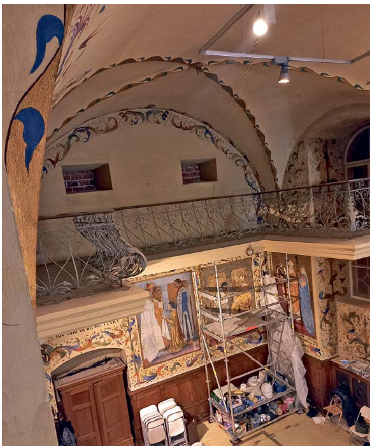
PRACE KONSERWATORSKIE W KAPLICY SEMINARYJNEJ
